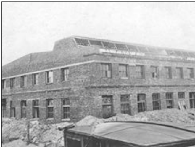
Строительство здания танкоремонтного цеха. 1938 год
