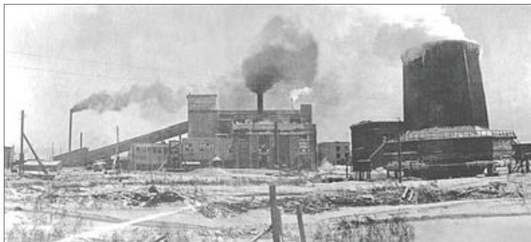
ТЭЦ авторемонтного завода. 1940-е годы
